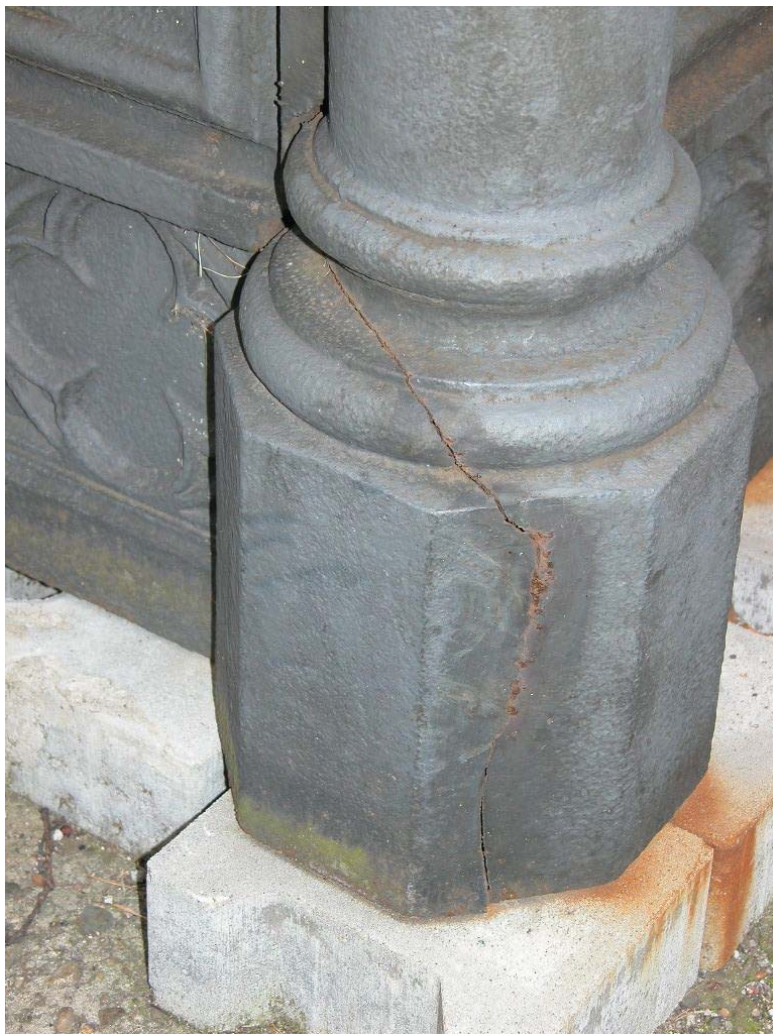
fot. 19. Gliwice, GZUT. Pomnik nagrobny J. Baildona, część żeliwna. Pęknięcie lewej tylnej podstawy kolumny. Stan w listopadzie 2010 r.
